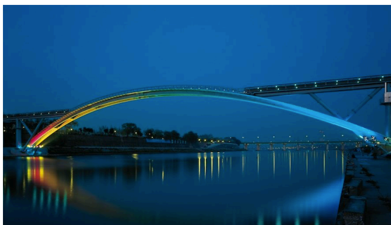
Figura 2.2 - Passarela Seonyu - Coreia do Sul (2004) [29]
